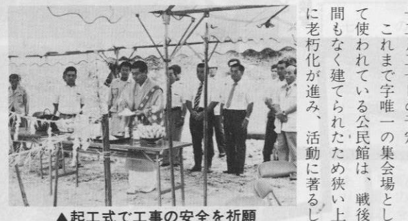
▲起工式で工事の安全を祈願
