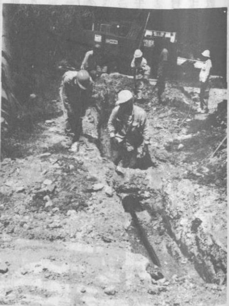
▶仲宗根地区簡易水道工事
