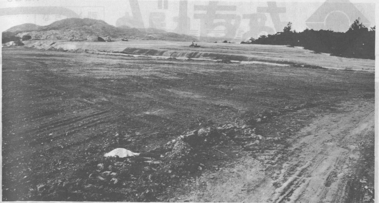
▲東部土地改良工事
