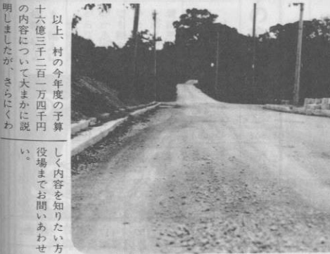
▲産業道路として期待される湧川運天線改良工事 (写真一夫底地区)
