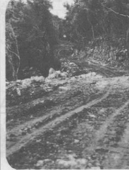
▲昨年に引き続き実施される林道新設事業
