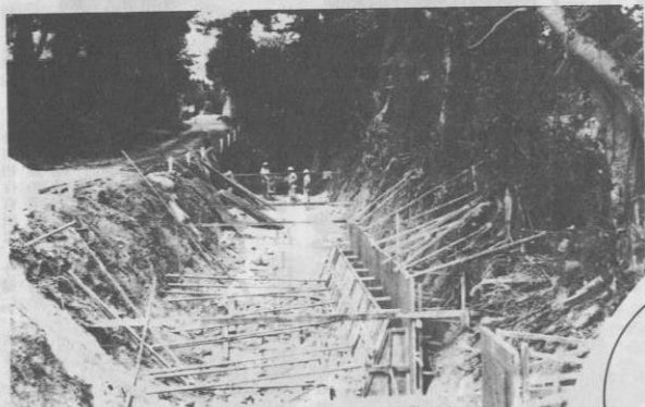
排水工事 0.31km
