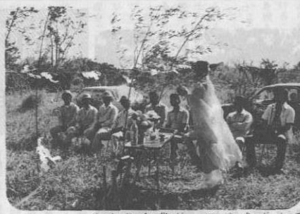
▲東部土地改良区の起工式
