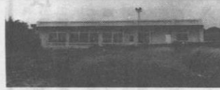
写真は新公民館正面(上)と全景(下)
