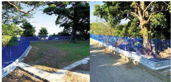
ハブ侵入防止ネット設置(天底小学校)
